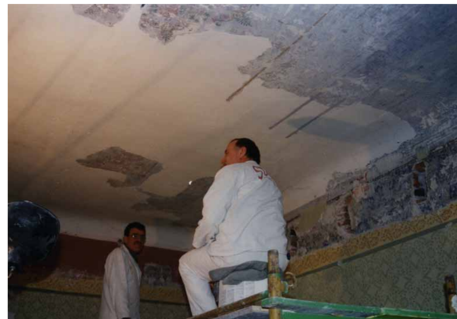
Odkrivanje in restavriranje poslikav v prvem nadstropju hiše (Arhiv ZVKDS OE Kranj)
