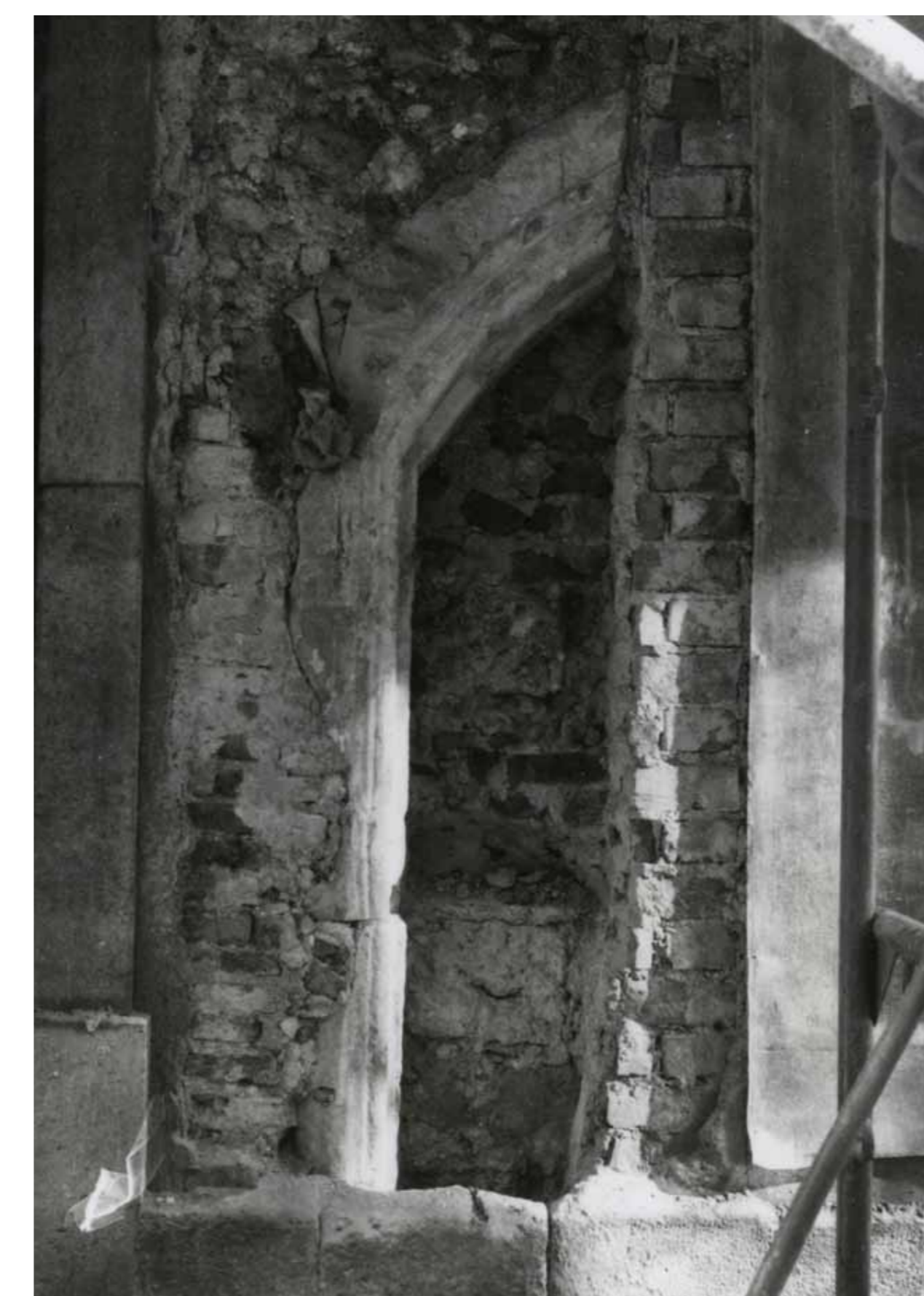
Raziskave fasade v Prešernovi ulici in del ohranjenega gotskega portala iz leta 1978 (Arhiv ZVKDS OE Kranj)
