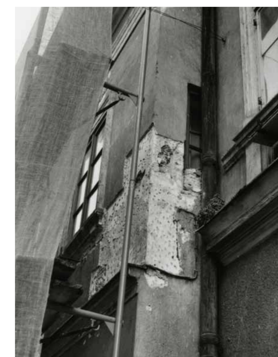
Obnova fasade v sedemdesetih letih 20. stoletja (Arhiv ZVKDS OE Kranj)
