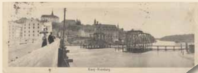
Gradnja Savskega mostu, 1909
